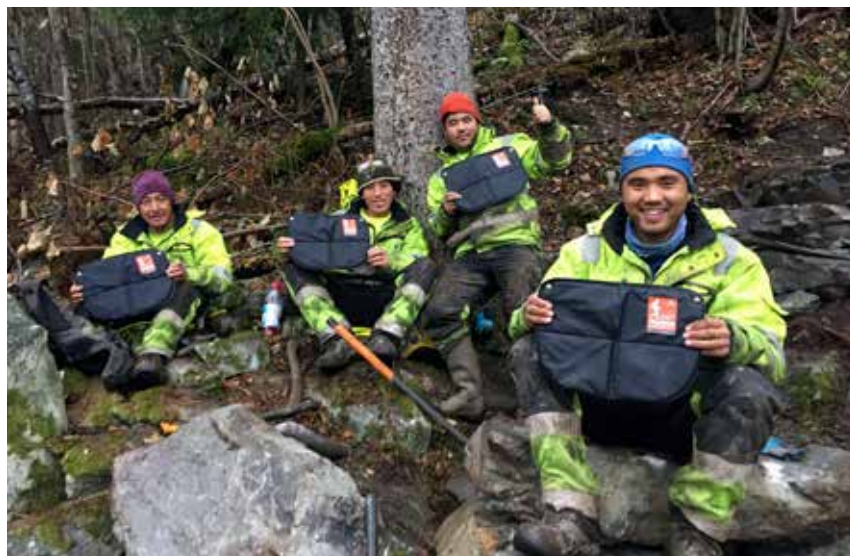
Sherpaer fra Nepal bygger steintrapp fra Dalen opp mot Ruiplassen i Telemark.
